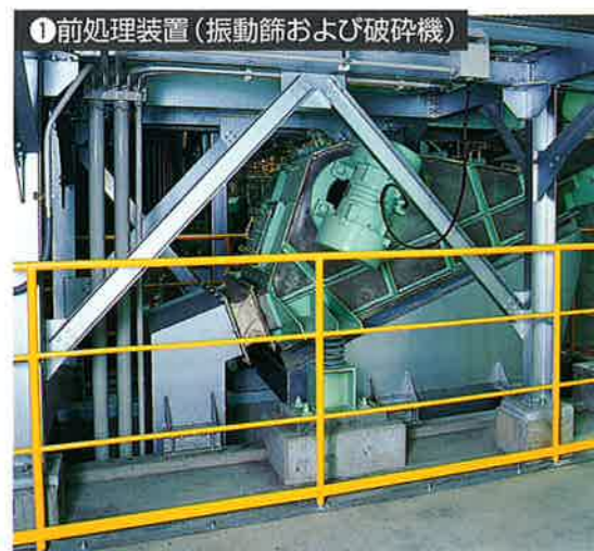
搬入される焼却灰（主灰および飛灰）および粗大残渣から粗粒物を選別して灰溶融炉へ投入可能となる粒度に破碎する装置です。
