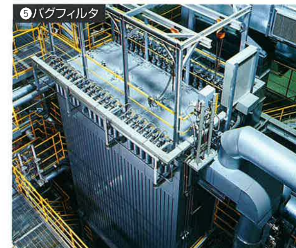
排ガス中のばいじんを除去し、指定の基準値以下にする装置です。なお、バグフィルタから払い落とされた集じん灰は溶融飛灰処理装置へ送られます。
