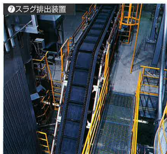
溶融炉で溶融されたスラグを冷却し排出する装置でスラグ搬出および搬送の各コンベアならびにスラグ貯留装置より構成されています。
