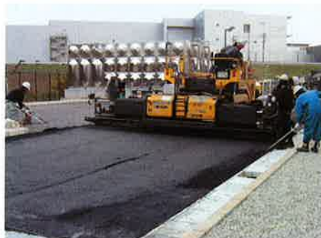
溶融スラグ入りアスファルト舗装工事の様子
