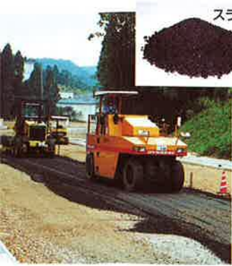
県道「多治見～善師野」改良工事例
