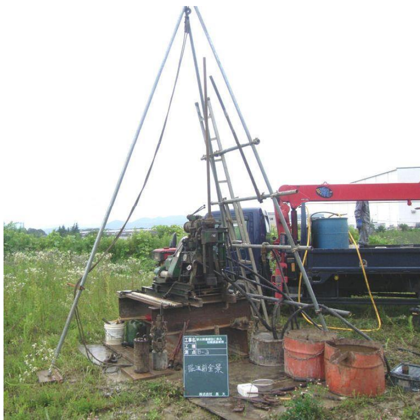
図2-1 ボーリング機械設置状況
