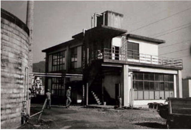
し尿消化処理機械棟
