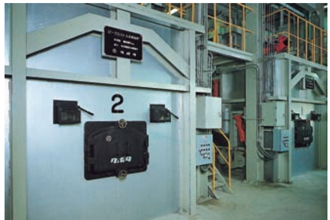
可燃ごみ処理施設焼却炉
