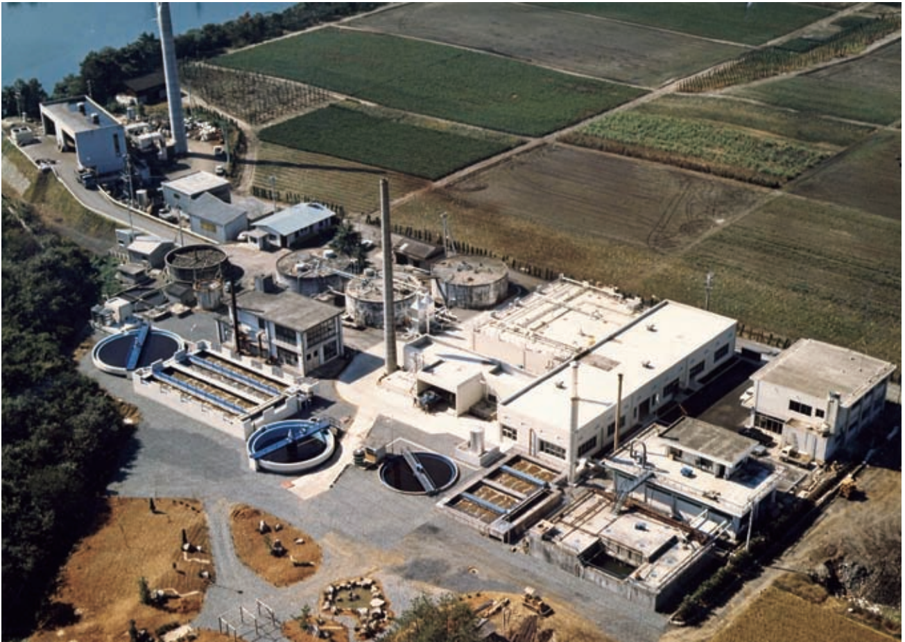
し尿処理施設第1プラント
