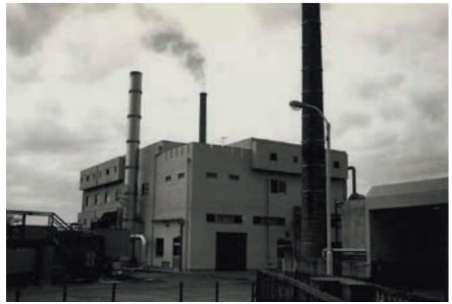
し尿処理施設第2プラント東側
