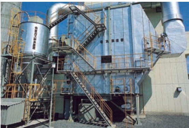
可燃ごみ処理施設排ガス処理設備
