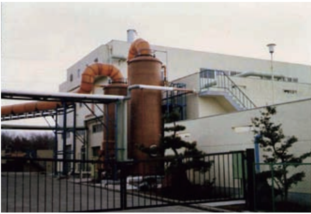
し尿処理施設第2プラント西側
