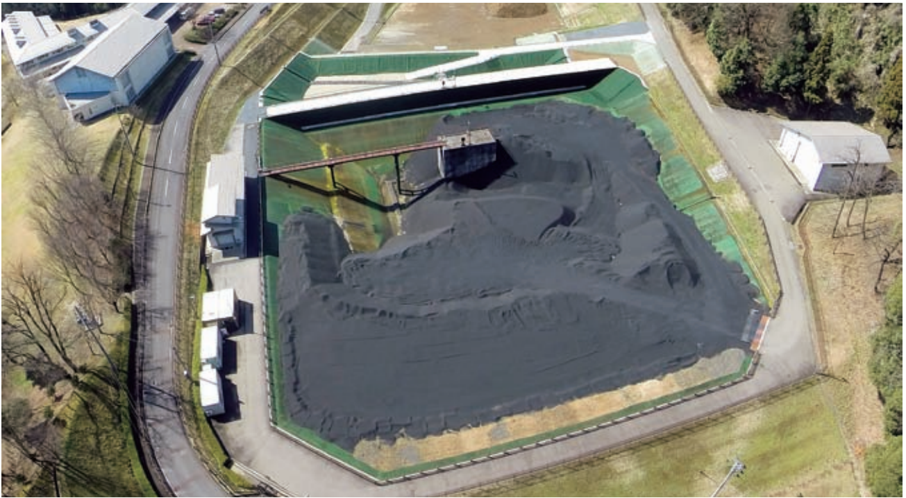
最終処分場・浸出水処理施設
