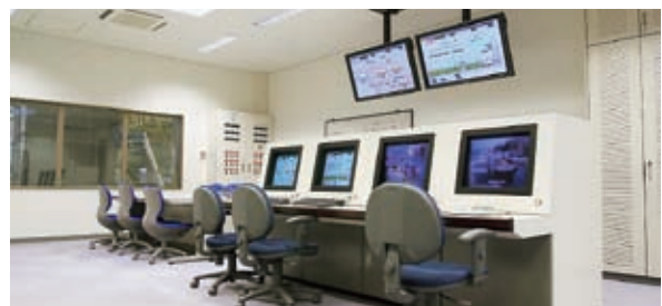
中央監視設備
