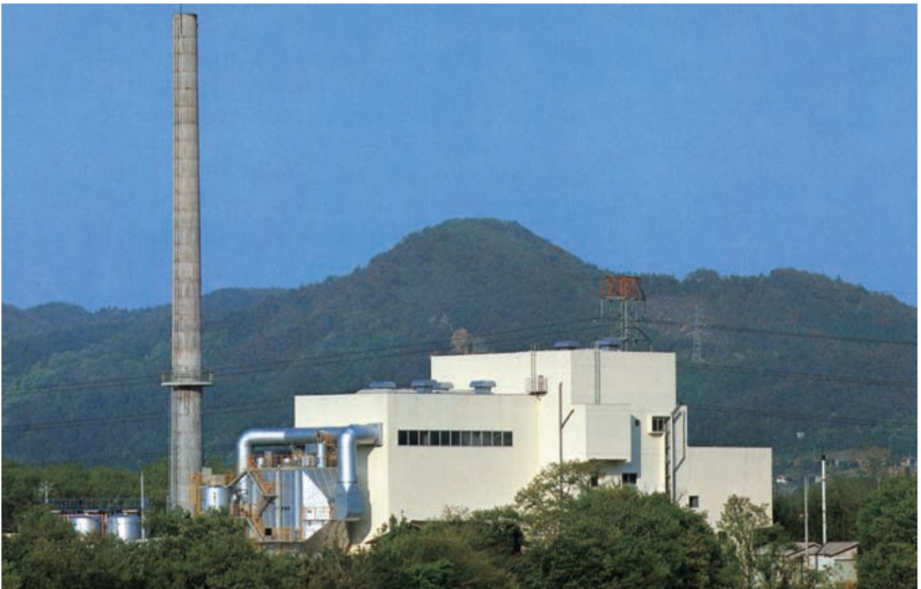
可燃ごみ処理施設
