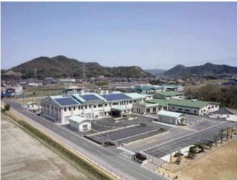
汚泥再生処理施設
