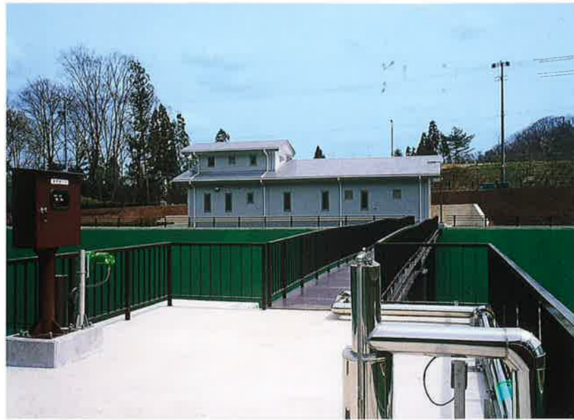
▲取水塔から浸出水処理施設棟へ
