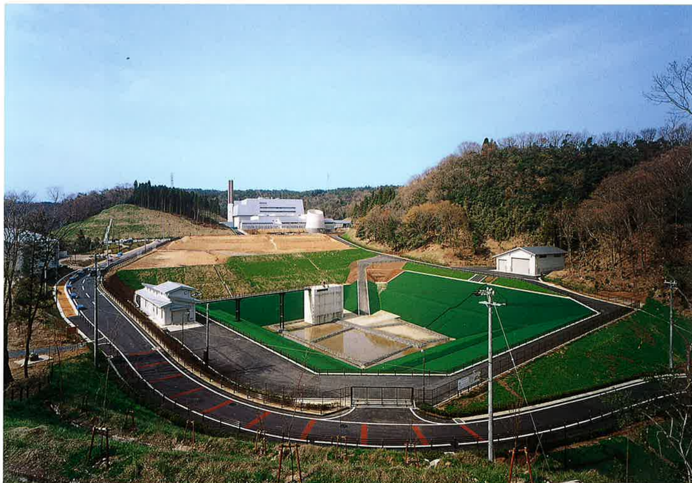
▲最終処分場施設全景
