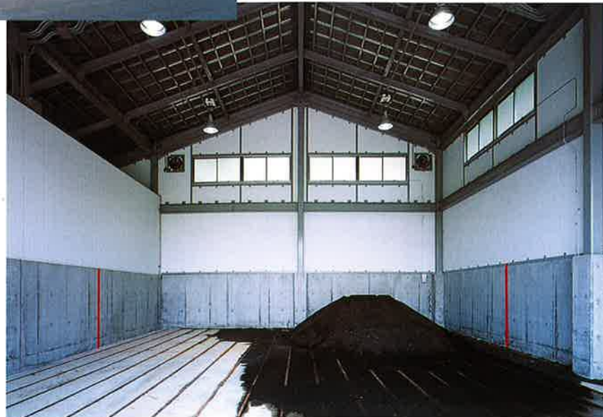
▲スラグ貯留庫
